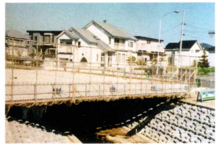
中野川6号橋新設工事
